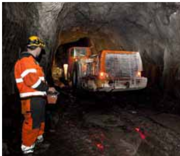
Lastning under jord med fjärrkontroll.
