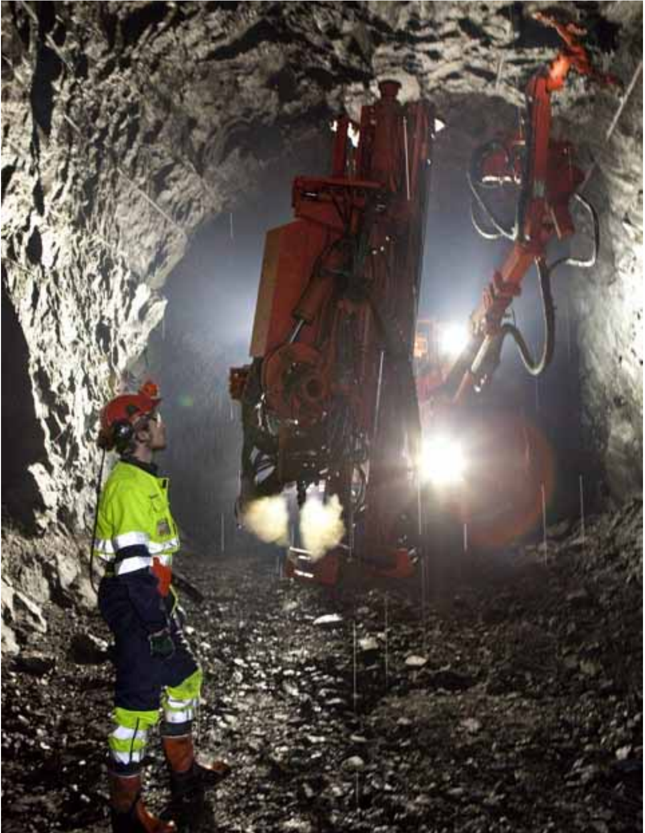
Bergförstärkning med stål nät och bultning.
